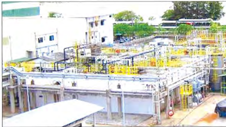
รูปที่ 6.4 ระบบบำบัดน้ำเสียแบบตะกอนเร่ง (Activated Sludge)
