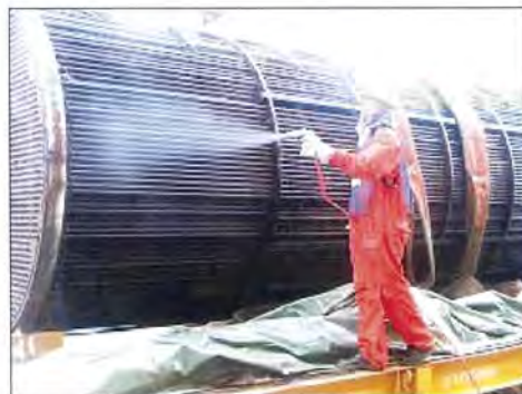
รูปที่ 7.6 ฉีดพ่นน้ำยาขณะถอดอุปกรณ์ออก
